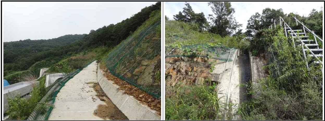
【그림 27.3.3】 배수시설 전경
